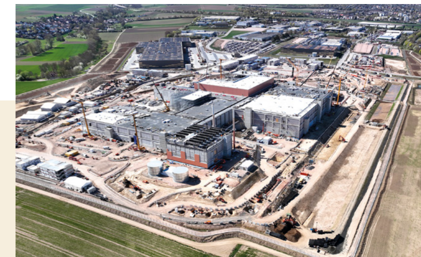
Anfang 2026 sind nahezu alle Gebäude im Rohbau fertiggestellt, der Innenausbau läuft.
