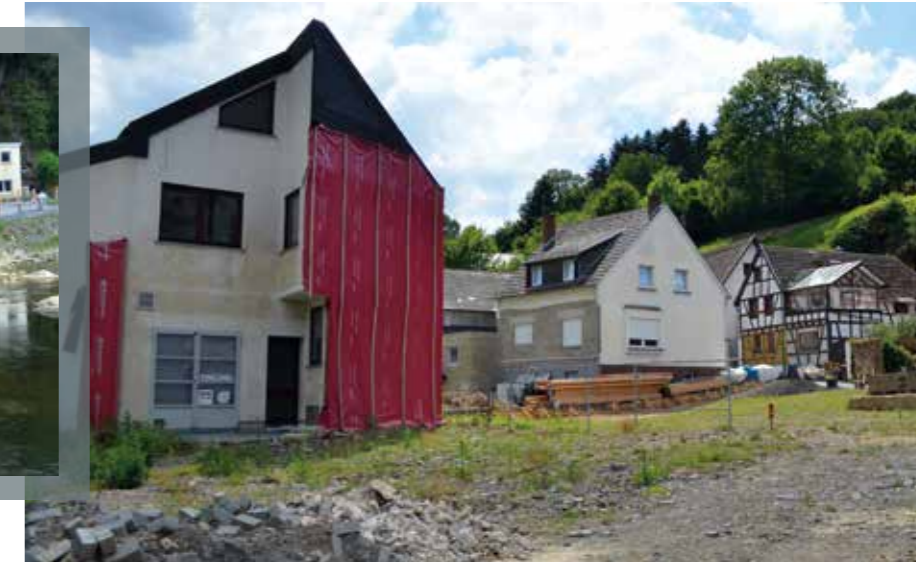
In manchen Straßenzügen sieht man Sanierungsfortschritte.
