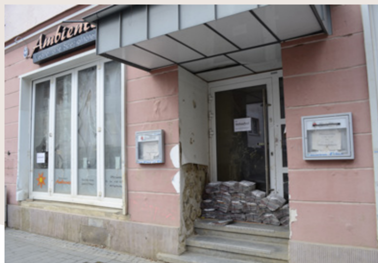
Manche Straßenzüge erstrahlen schon wieder im alten Glanz, in anderen Ecken herrscht noch Baustillstand.
