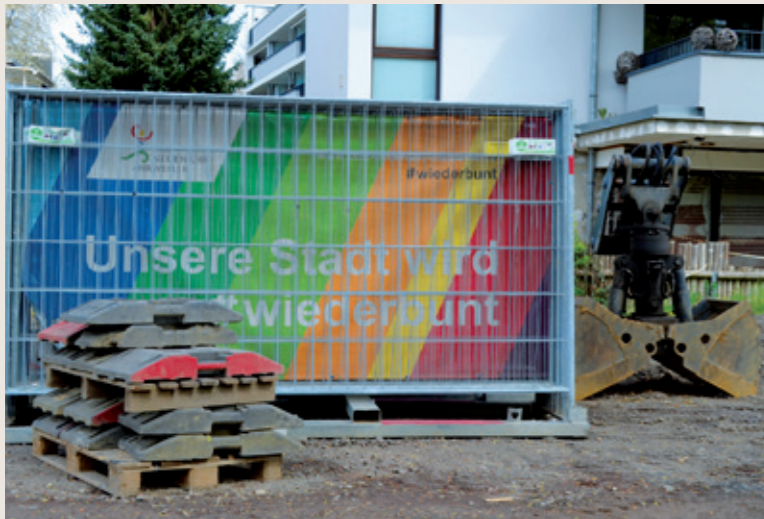
Baustellen prägen vereinzelt noch das Stadtbild.
