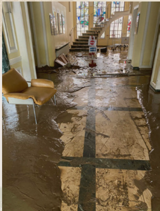
Haupteingang: vorher - nachher
