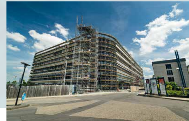
Das Bundeswehrzentralkrankenhaus wird bereits seit 2014 umfangreich modernisiert und ausgebaut.
